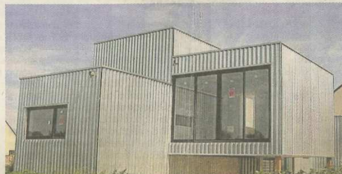
Des formes épurées et une structure qui permet les adjonctions.
